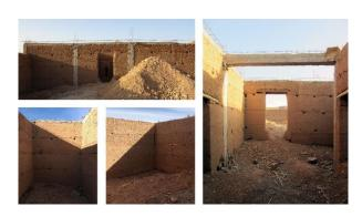
Ne è emerso un manufatto che necessitava dapprima di opere di ripristino (ad esempio interventi sulle fondazioni) e poi di completamento e riqualificazione. La presenza di una maglia di pilastri, irregolare, debole e di scarsa qualità, insieme con la verifica del mancato ammorsamento di alcuni cantonali, hanno fatto sì che la copertura, inizialmente pensata in appoggio alla struttura esistente, fosse realizzata in modo indipendente.
