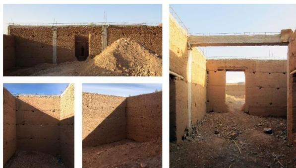
Surgió un artefacto que primero necesitaba trabajos de restauración (por ejemplo, trabajo en las fundaciones) y luego finalización y remodelación. La presencia de una malla de pilares irregular, débil y de mala calidad, junto con
