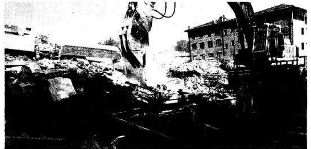
Macerie di un palazzo pericolante e abbattuto: i detriti dovrebbero servire per il fondo della futura autostrada
