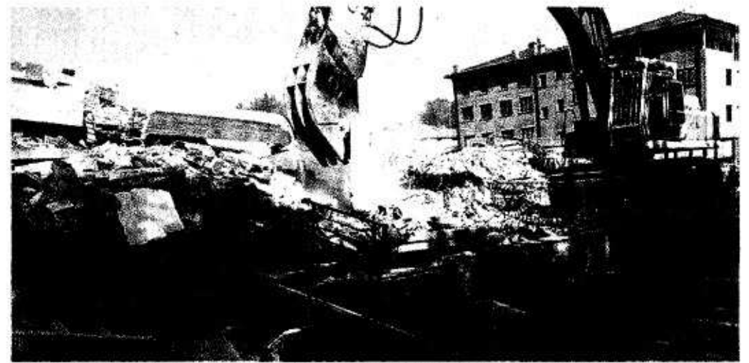
Macerie di un palazzo pericolante e abbattuto: i detriti dovrebbero servire per il fondo della futura autostrada
